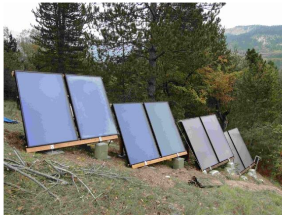
Figure 2: les 8 capteurs, photo prise vers le nord-est
